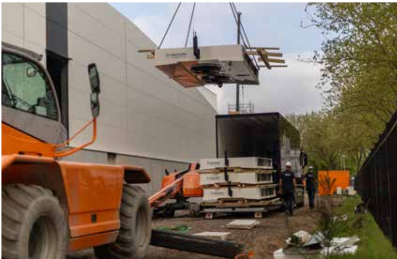
Een verreiker zet de verdamper op de juiste verdieping ...
